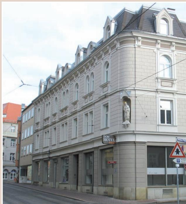
Das Gebäude Frauentorstraße 8 beherbergt das Domhotel. Der Zahn der Zeit hatte an Dach und Fassade genagt und eine Reparatur erforderlich gemacht. Die Schadstellen wurden ausgebessert und die Fassade durch einen Wiederholungsanstrich aufgefrischt. Auf den durch eine Befunduntersuchung ermittelten rötlichen Anstrich des 19. Jahrhunderts wurde dabei zugunsten der gewohnten Farbgebung verzichtet.
